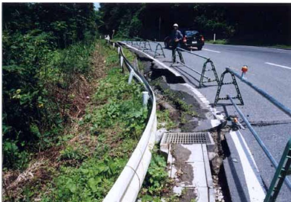
第4図 地点2. 旭山南方. 路肩が崩壊し, 斜面方向（左）に落ちている.
