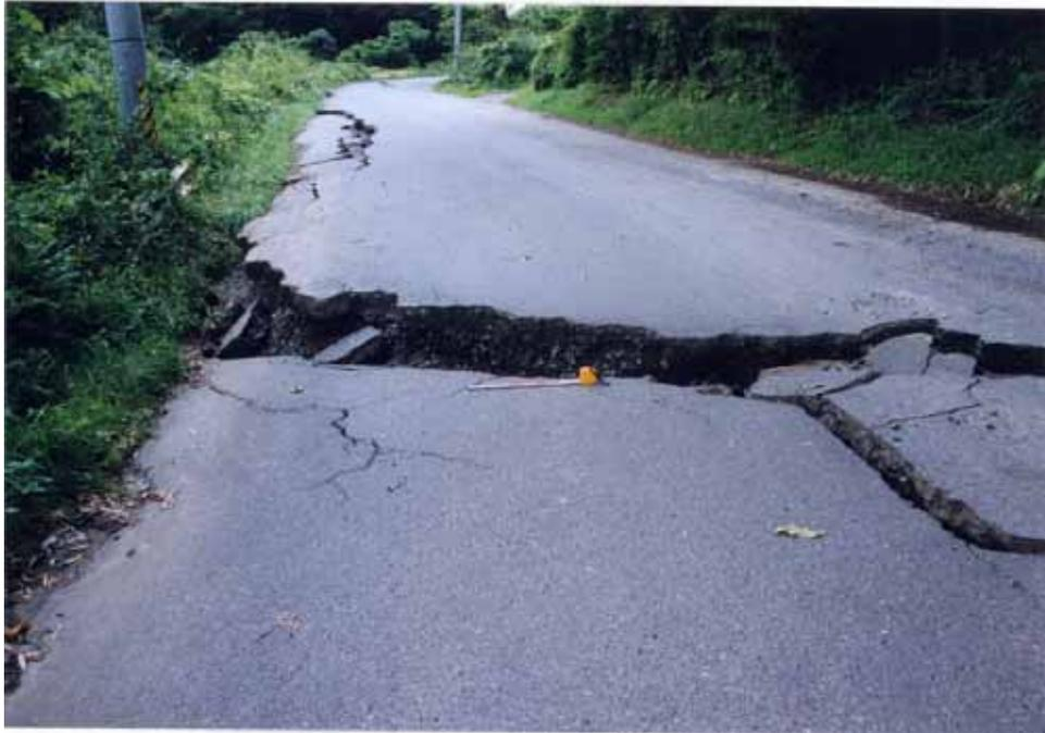
第 6 図 地点 3. 道路横断方向の開口割れ目および路肩の崩壊.
