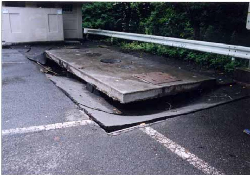
第3図 地点1. 旭山南方登山道脇. 駐車場の盛り土部分が谷方向（写真奥）に移動しながら陥没, 浄化槽が浮き上がっている.
