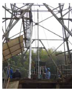
総合観測装置の埋設設置の直前
