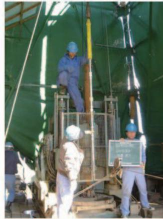
応力測定用のインテリジェント型歪計の設置
