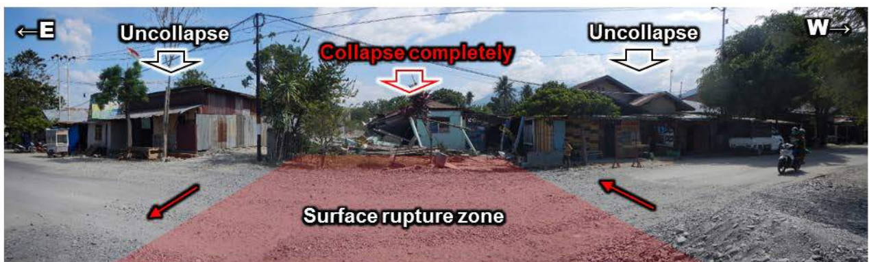
第8図 地表地震断層帯上の家屋倒壊とその脇で倒壊を免れた家屋（20181102-10地点）
