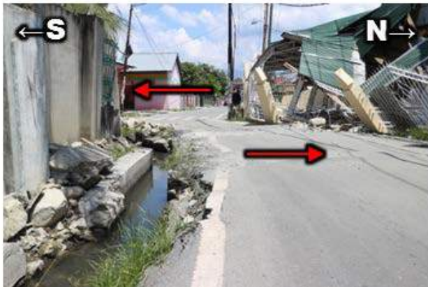
第5図 20181102-6地点（Cwmara street）における左横ずれ地表地震断層（赤破線部）
