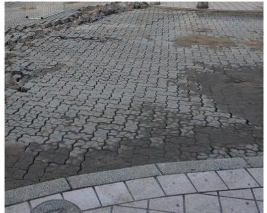
写真 8-12 : 道路の亀裂及び液状化
