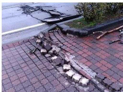
写真 8-4 : 道路の亀裂及び段差
