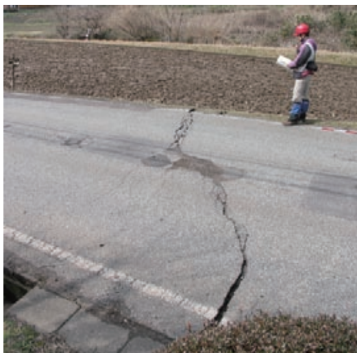
第3図 中野屋地区において県道を横切る地震断層。図2の地点1。南西方向を見る。
