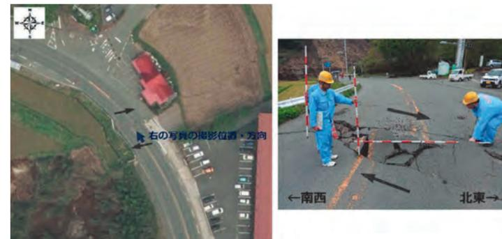
図-37b 航空写真で確認できる右横ずれの亀裂（左）と同地点の現地写真（右：2016 年 4 月 18 日撮影）。右の現地写真では、道路のセンターラインが約 1.2m 右横ずれしている（赤白ボールの 1 目盛は 20cm）。
